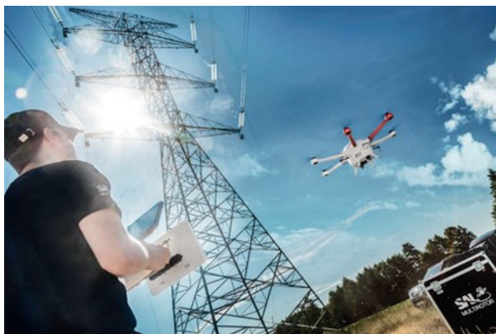
Rys. 25. Rozwieszanie liny wstępnej z wykorzystaniem dronów latających podczas budowy napowietrznych linii wysokiego napięcia
